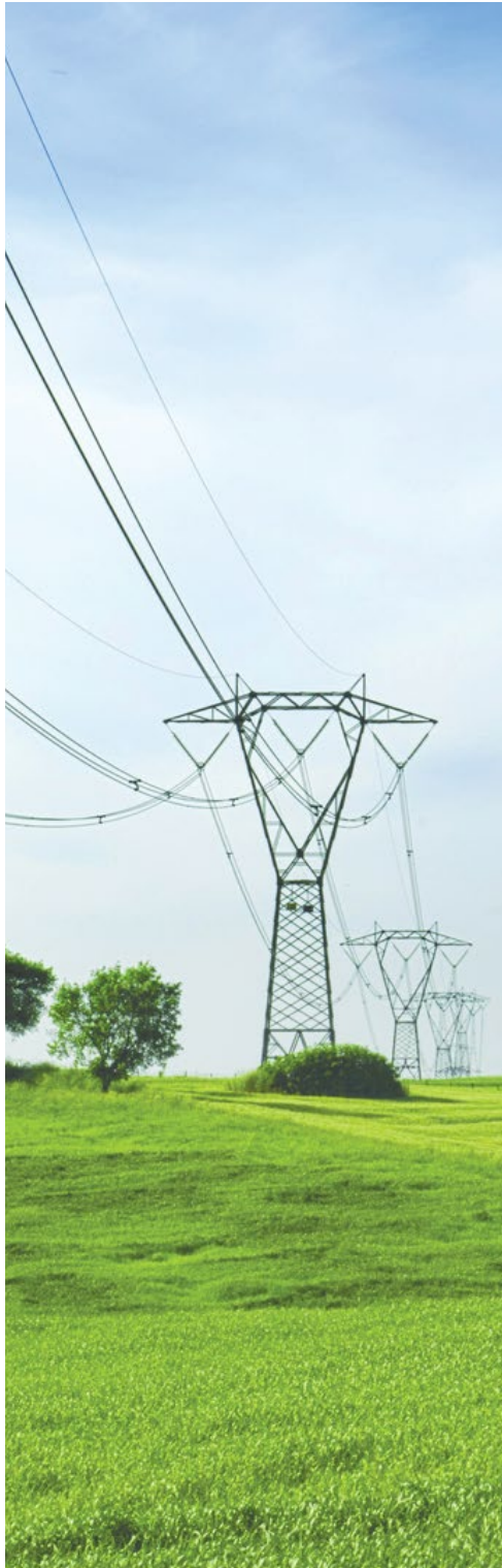
Linia najwyższego napięcia
